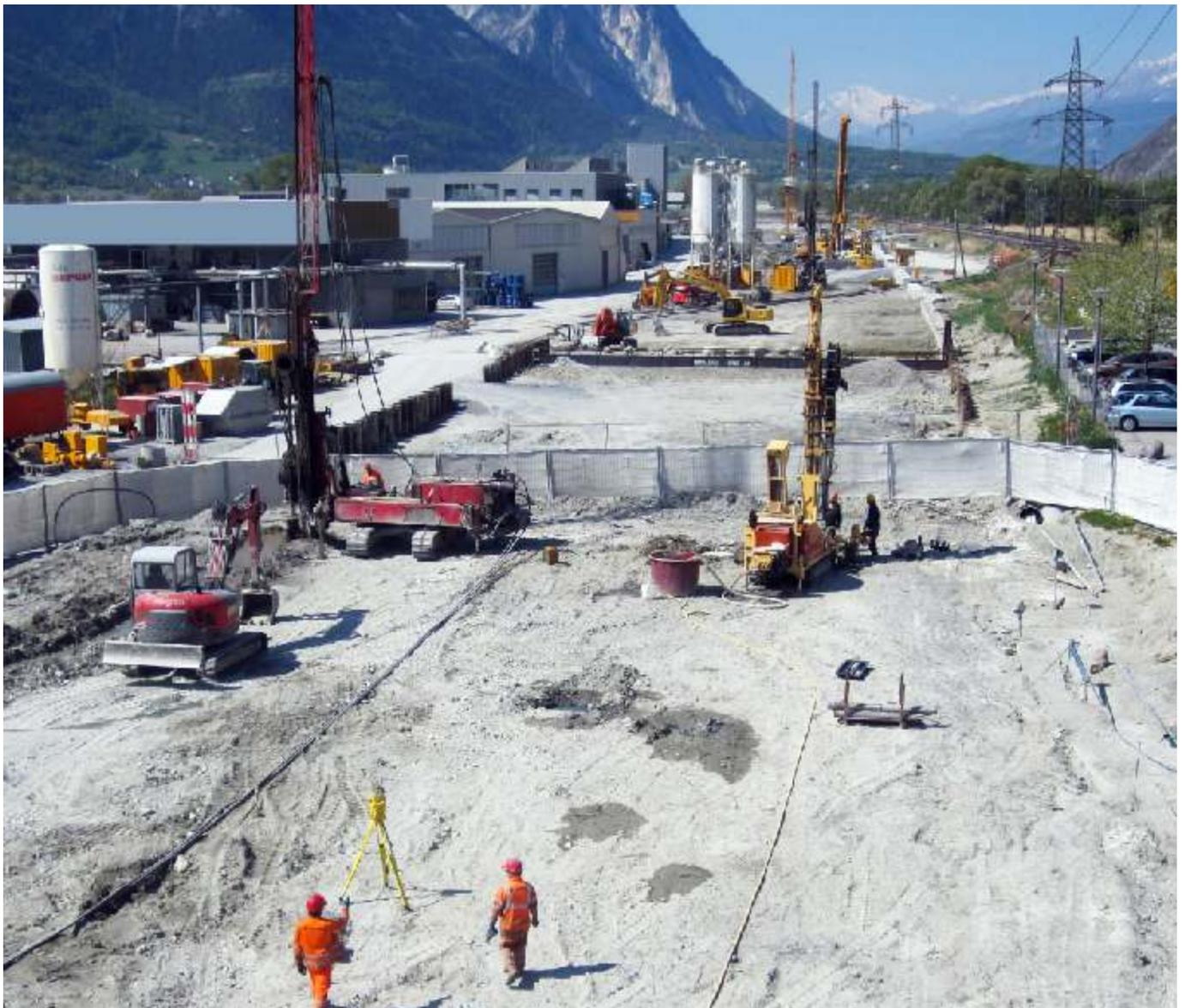
Foreuses en travail pour la réalisation de la dalle de fond en jet grouting
