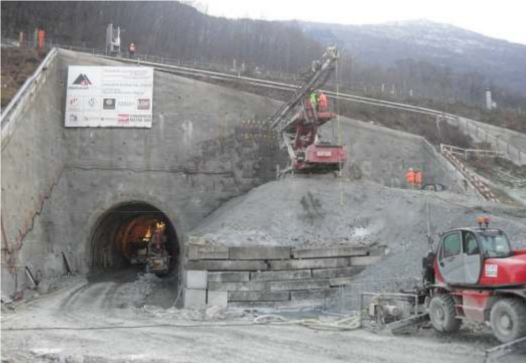
Foreuse SR510 en travail sur la calotte supérieure
