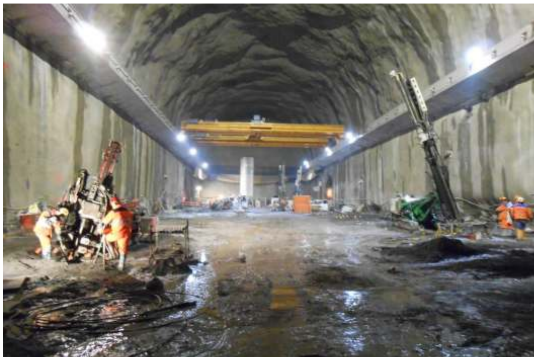
Foreuses en perforation dans la caverne
