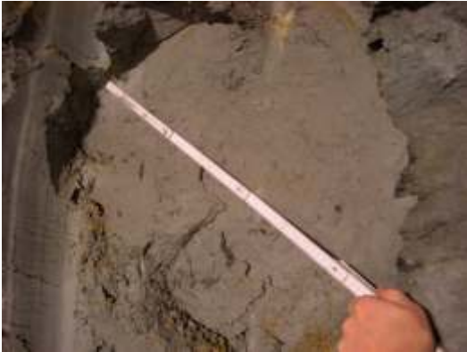
Colonne Jet Grouting exposé
