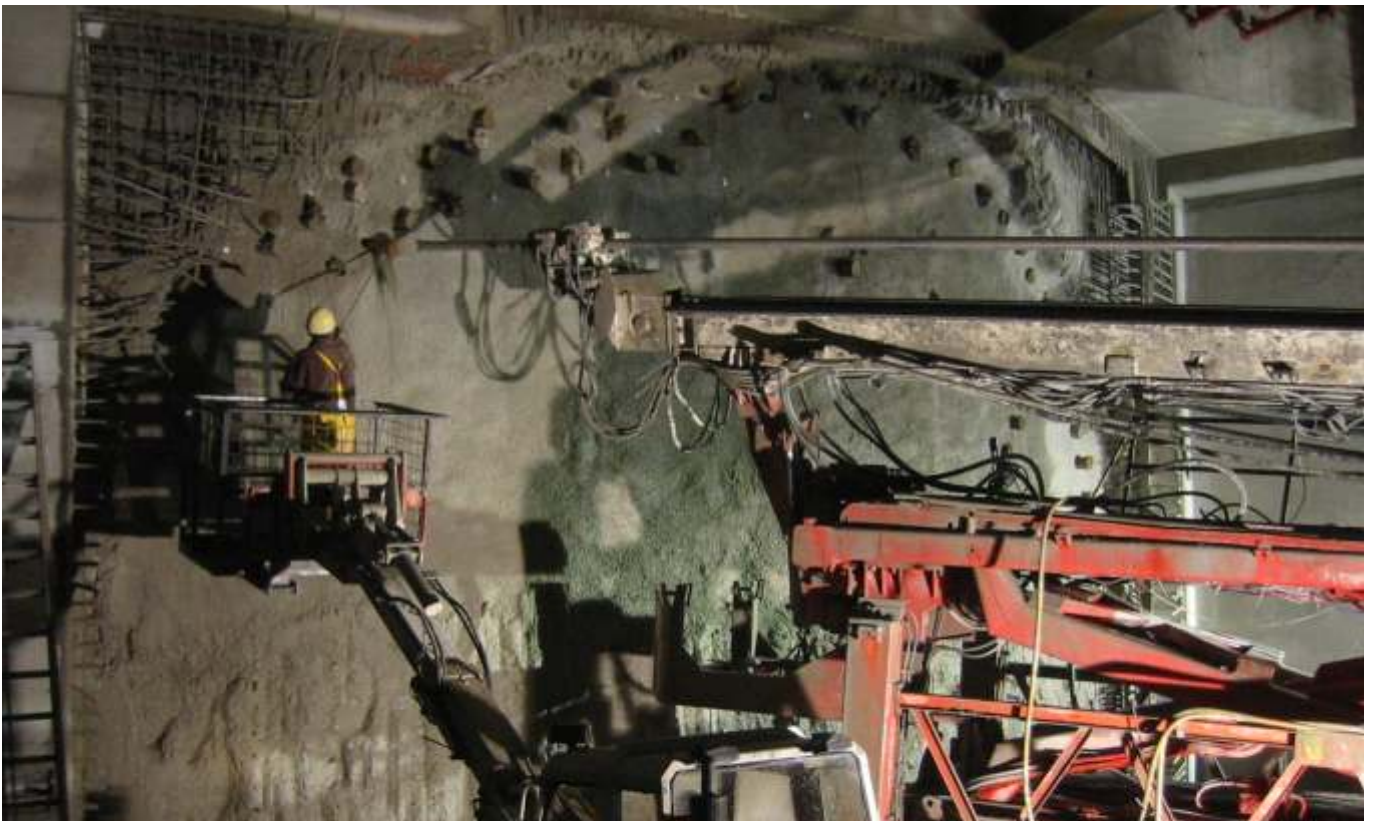
Mise en place du bouchon
