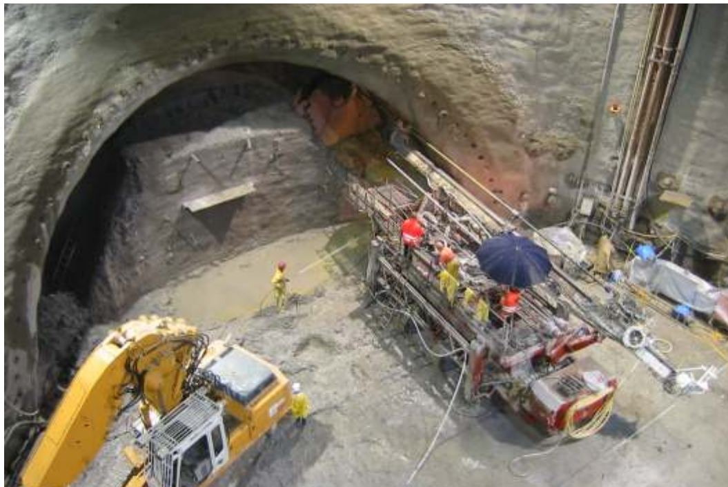
Foreuse RODIO SR 510 dans le puits d'attaque
