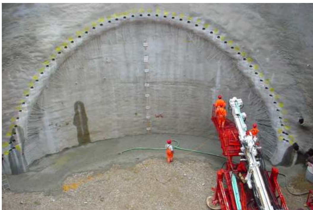
Foreuse RODIO SR 510 dans le puits d'attaque
