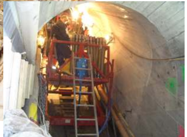
Centrale RODIO de malaxage et d'injection
