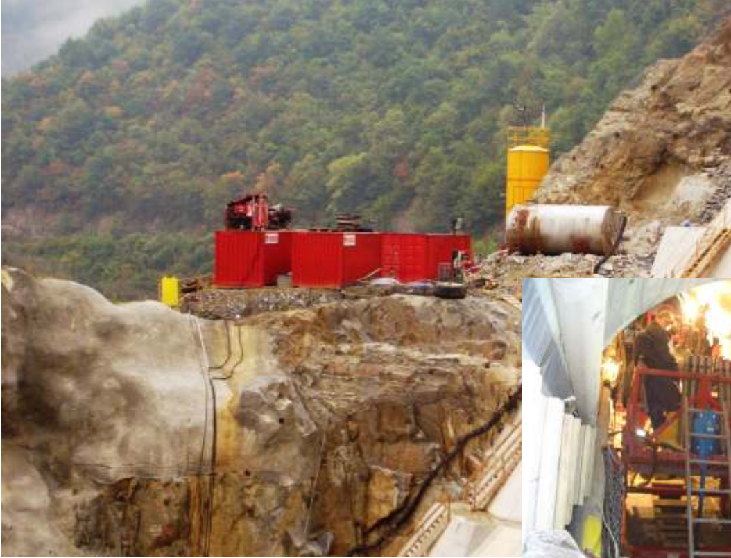
Centrale RODIO de malaxage et d'injection
