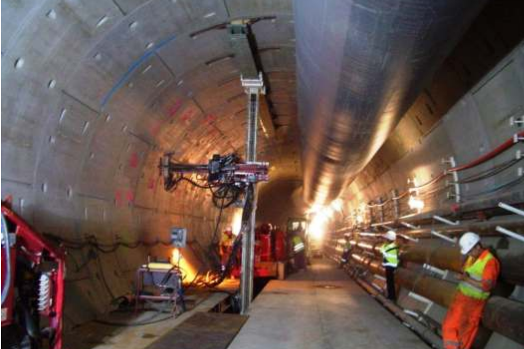
Foreuse installé su mât vertical
