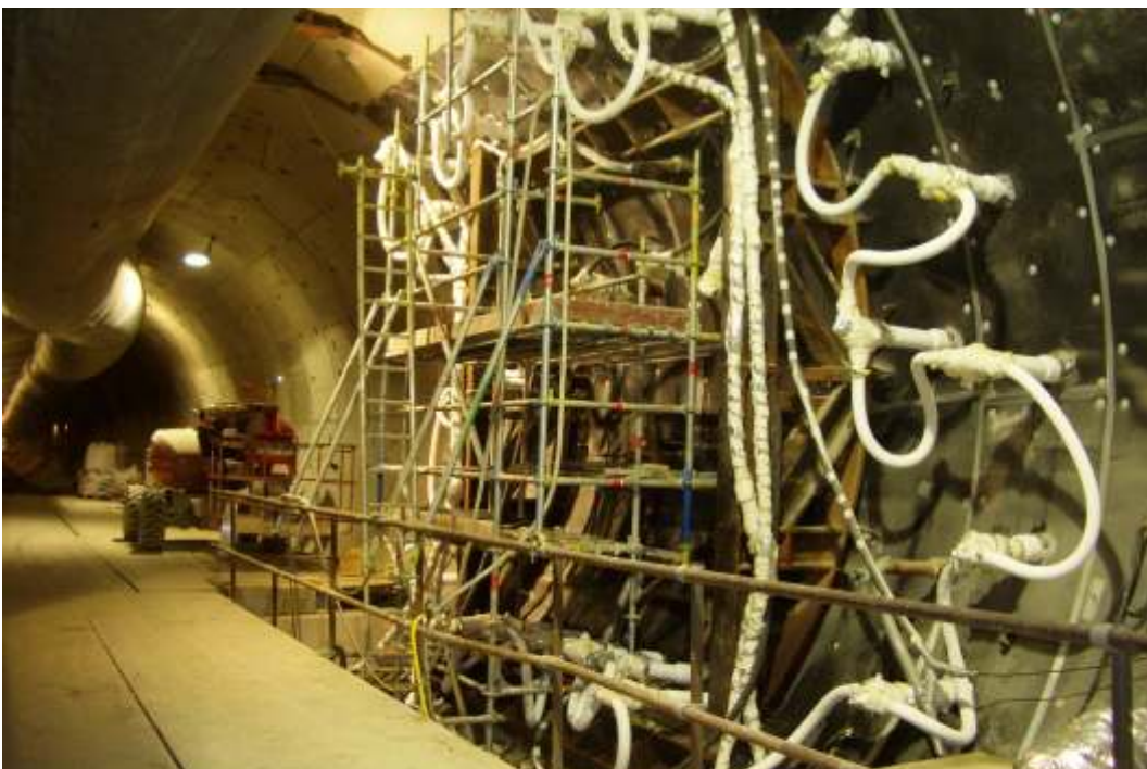
Circuit de distribution de saumure et structure de renforcement
