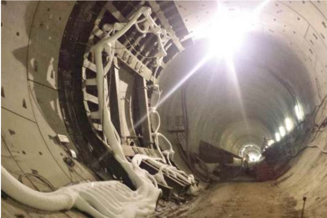
Un cross passage en phase de congélation
