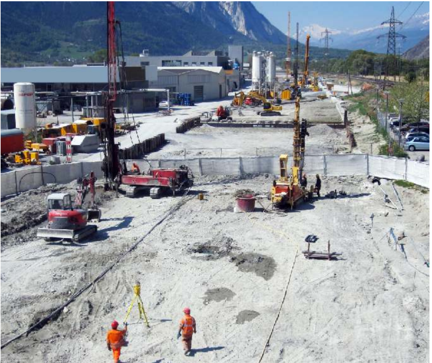
Bohrgeräte im Einsatz für die Herstellung der HDI-Sohle
