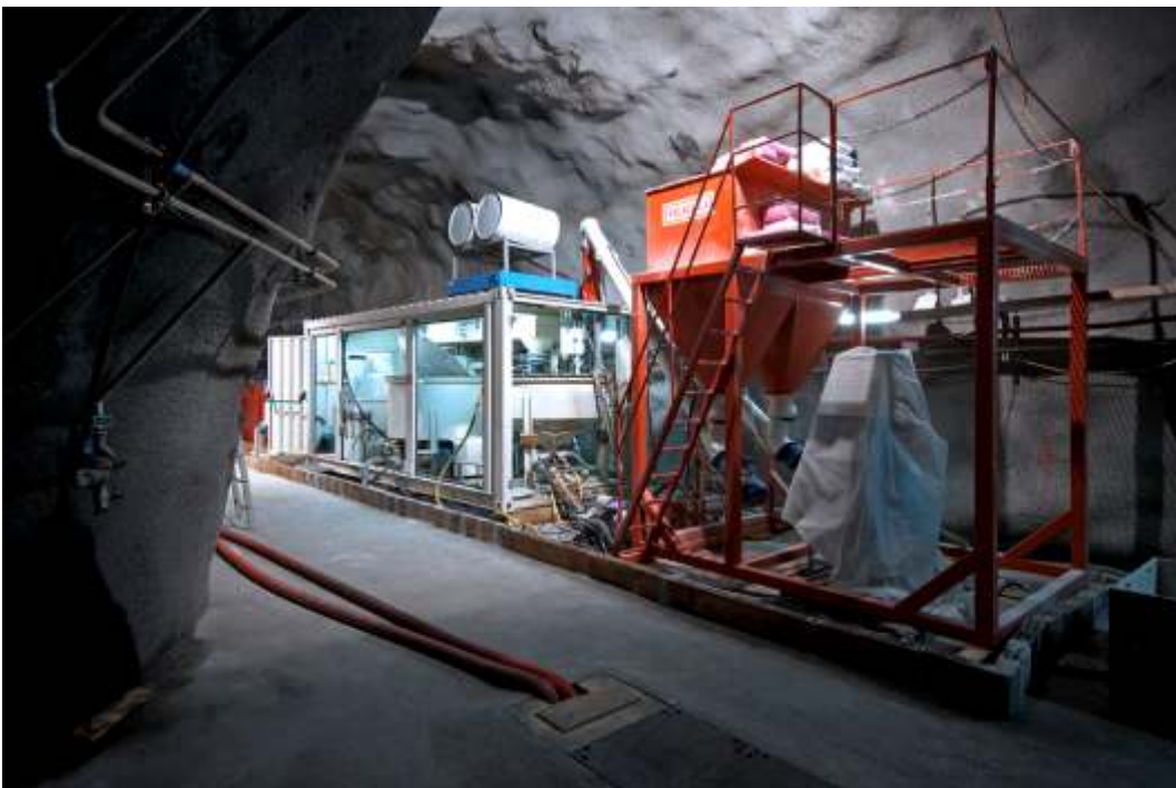
Misch- und Injektionszentrale in der Kaverne
