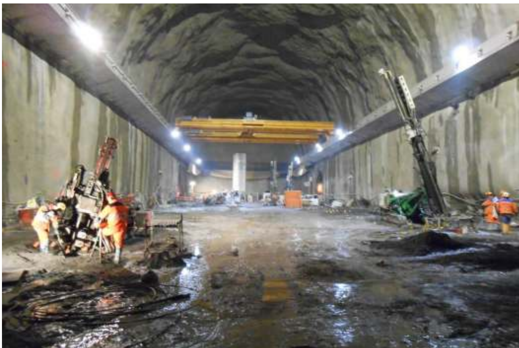
Bohrgeräte in Arbeit in die Kaverne
