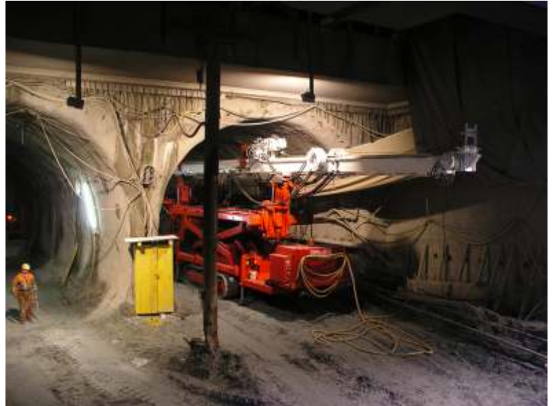
Bohrgerät RODIO Sr510
