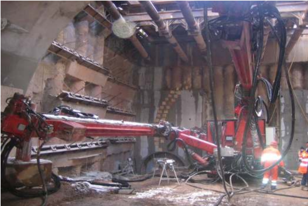
Tunnelbohrgerät JM140 mit Doppel Lafette im Startschacht
