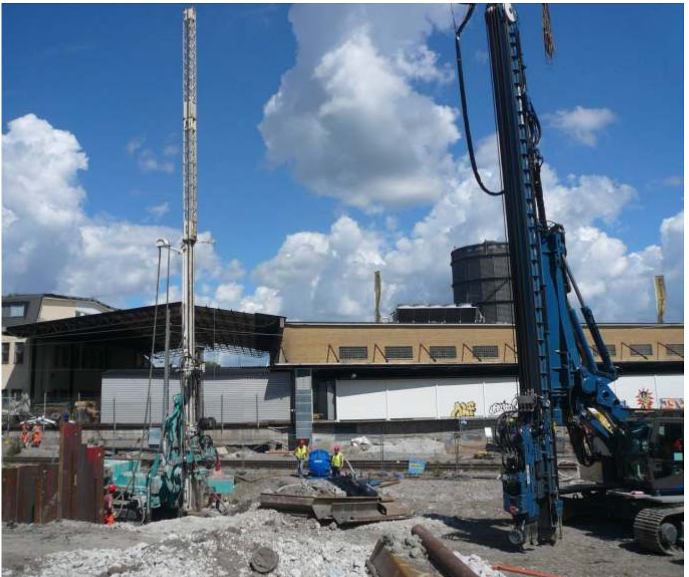
Bohrgerät Casagrande C8 Super in Arbeit
