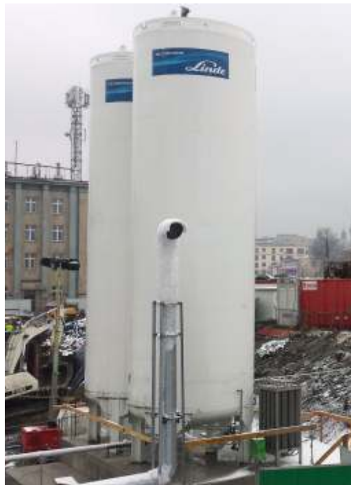
Silos für flüssigem Stickstoff
