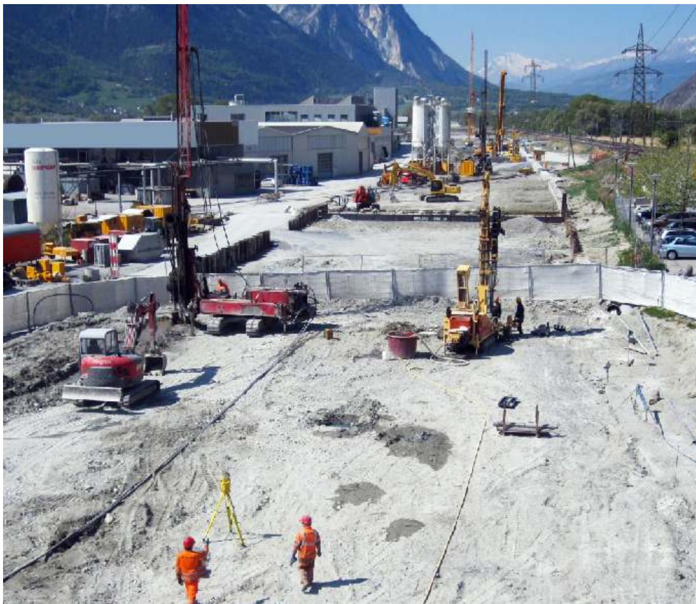
Attrezzature in lavorazione per la realizzazione del fondello Jet Grouting
