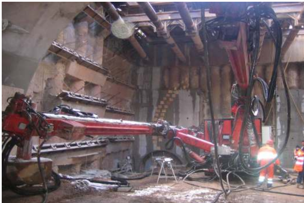
Posizionatore a doppio braccio JM140 nel pozzo di partenza
