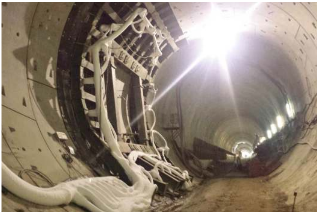
Un cunicolo di collegamento in fase di congelamento
